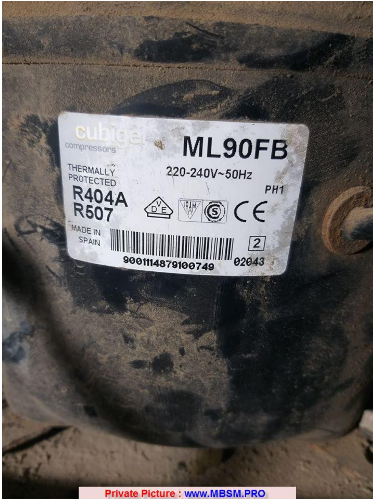
ML90FB ,CUBIGEL ,R404A / R507, LBP, COMPRESSEUR HERMÉTIQUE ,1/3HP, 230V 50Hz
