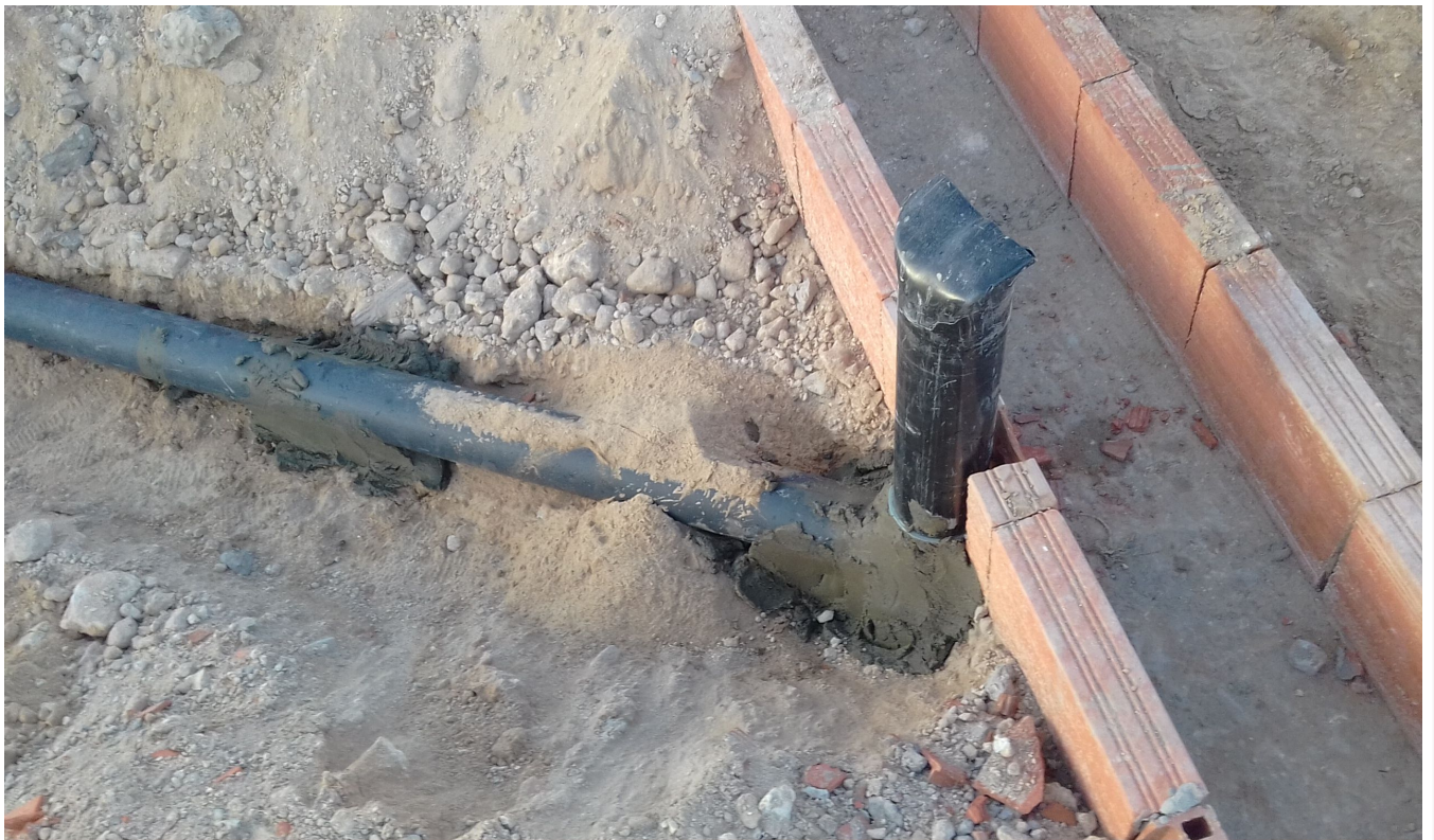
Mbsm.pro , Plomberie , Base de Pvc, Nouvelle installation
