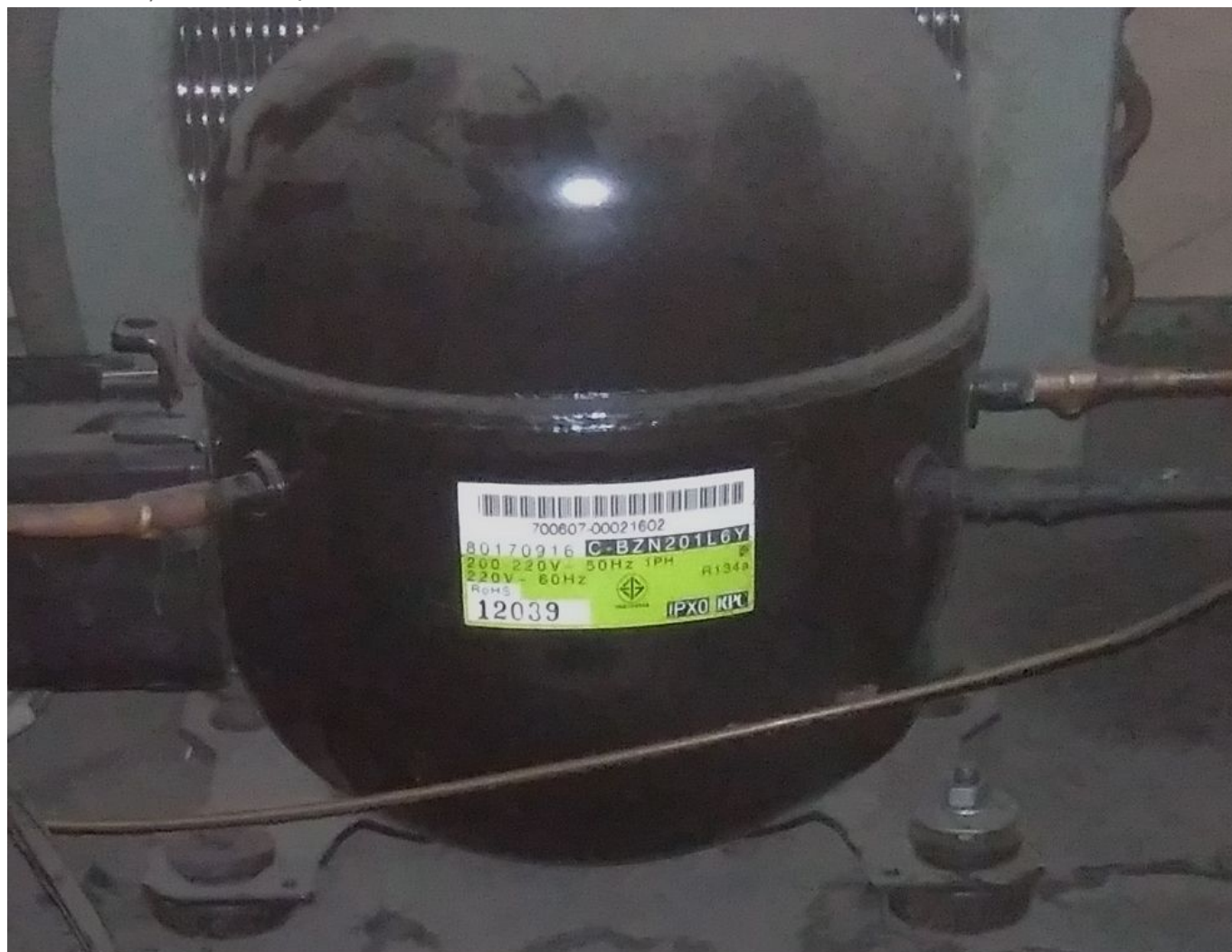
Compresseur Sanyo C-BZN201L6Y, 1 / 4cv
