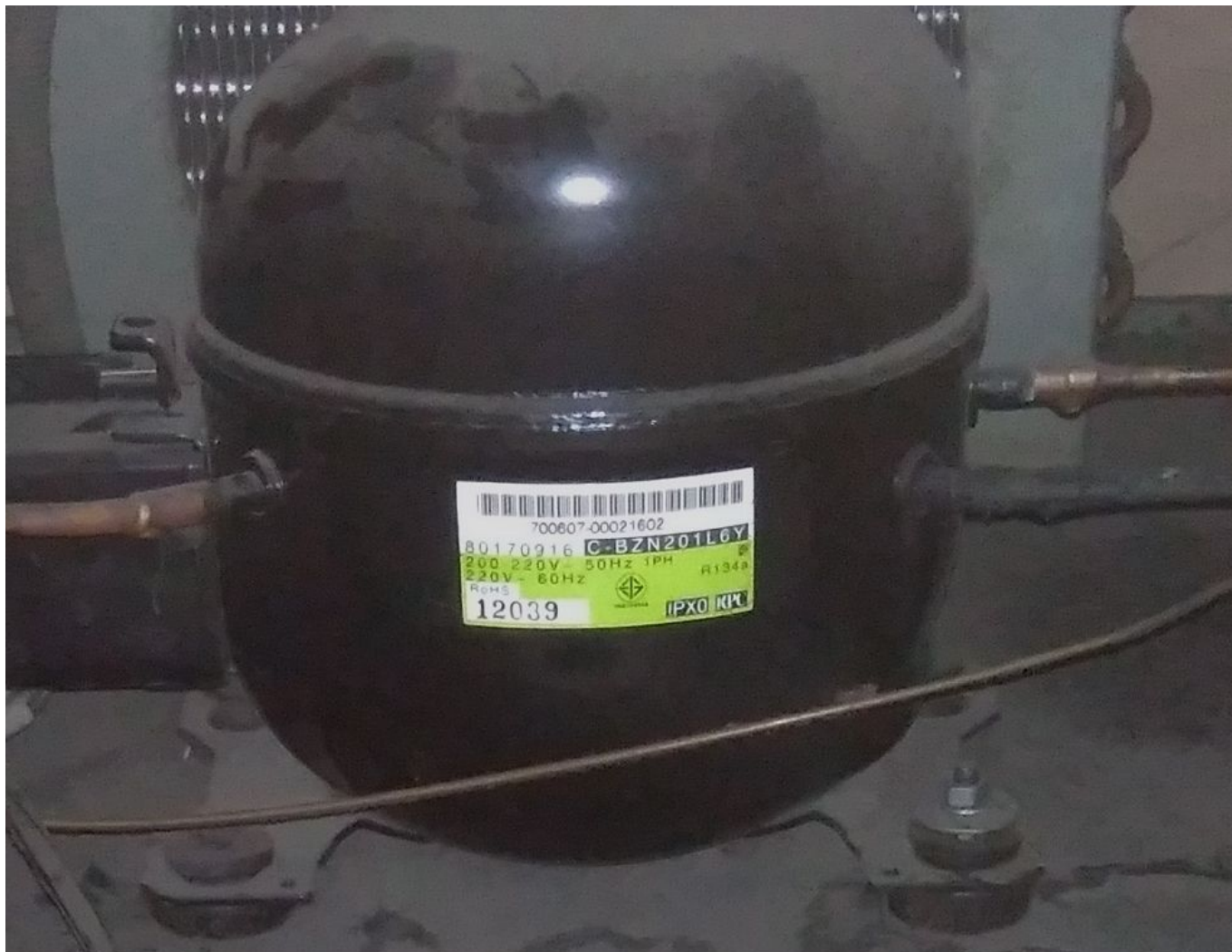
Compresseur Sanyo C-BZN201L6Y, 1 / 4cv
