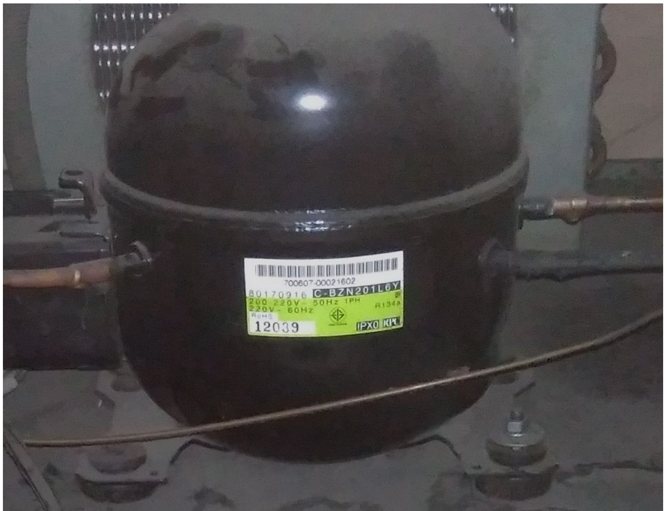
Compresseur Sanyo C-BZN201L6Y, 1 / 4cv
