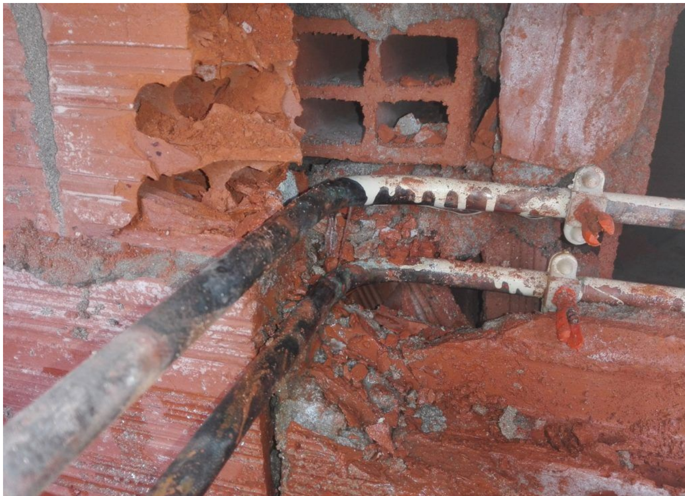
Erreur grave ,Fuite cuivre sans isolation plastique
