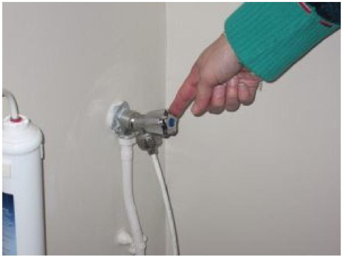
Il faut enlever le filtre du frigo américain en coupant le tuyau à rase sans oublier de préparer un sceau pour éviter que de l'eau ne coule au sol
